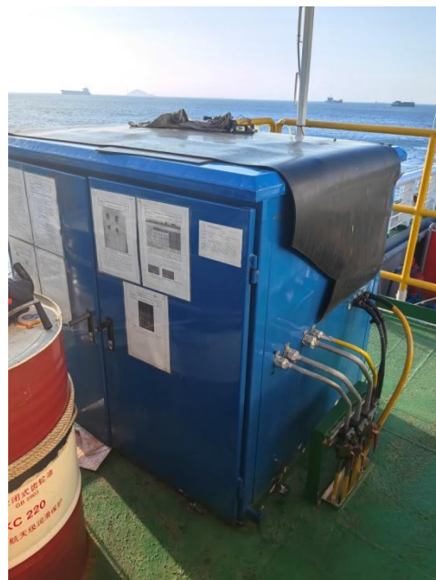
钻柱升降补偿系统— 补偿液压站
