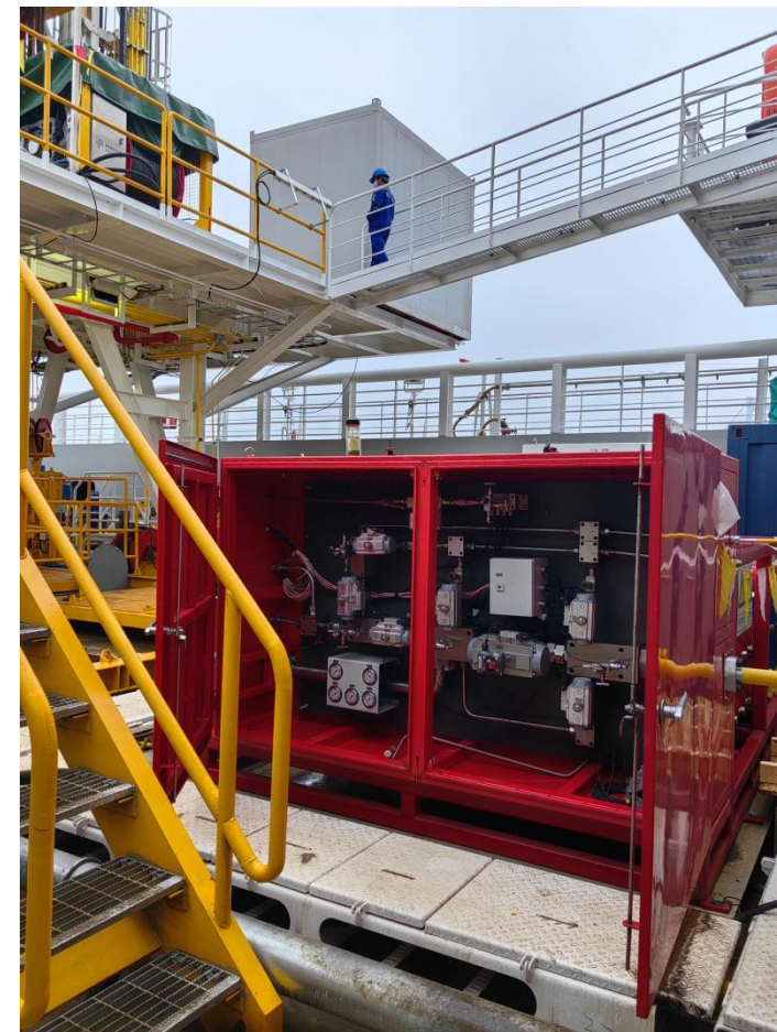
钻柱升降补偿系统-高压气动阀组
